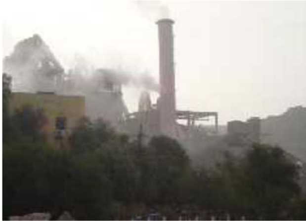
Ancienne cheminée avec électrofiltre
