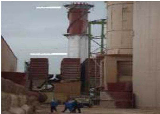
Nouvelle cheminée avec filtre à manche
